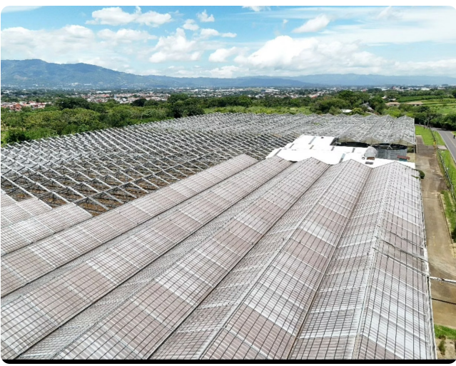
Detalle de las estructuras del invernadero
