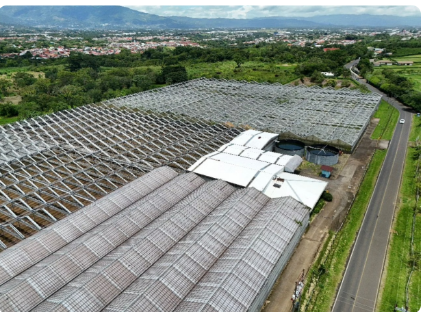
Vista aérea de las instalaciones completas
